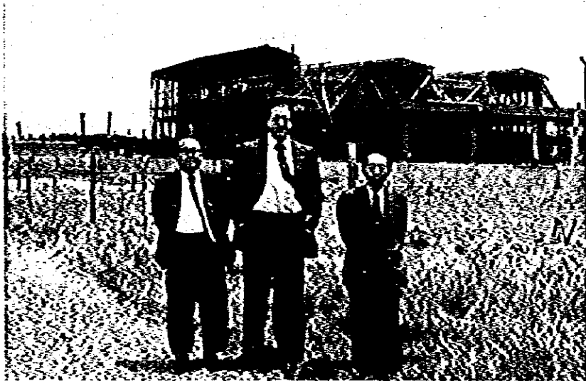
新LATU 建設現場にて
