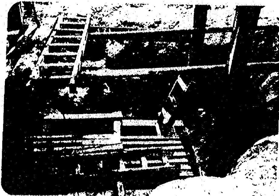
FOT. N° 19 Chimenea de acceso a la mina
