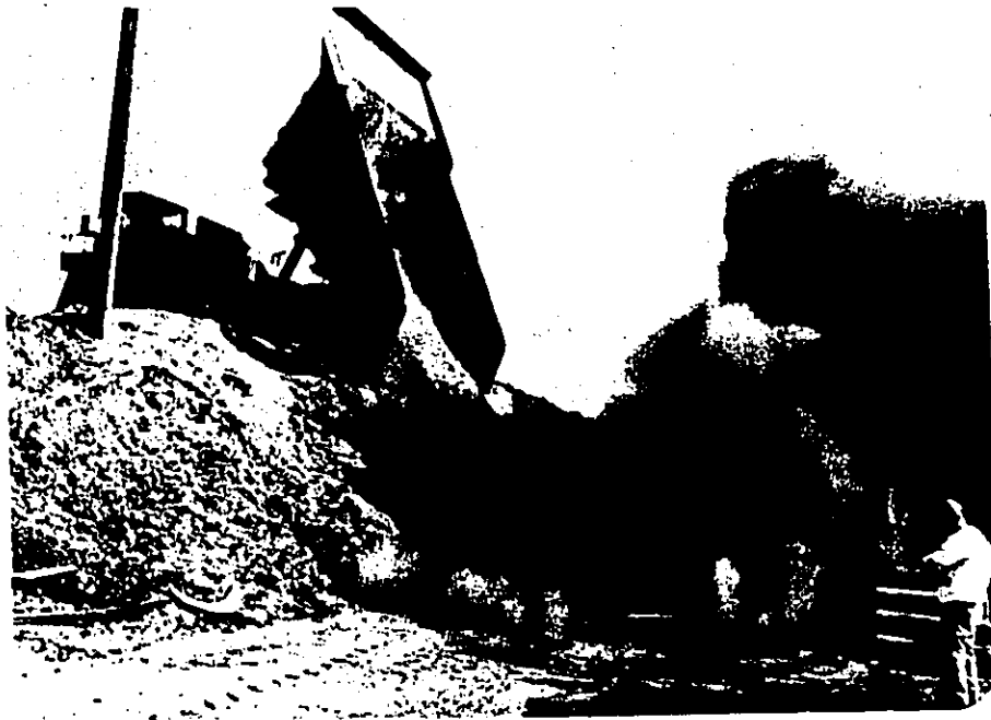
Momento en que se descarga mineral a la tolva nótese la cantidad de polvo. Ing. Nakamura tomando medición con el medidor digital de polvo.
