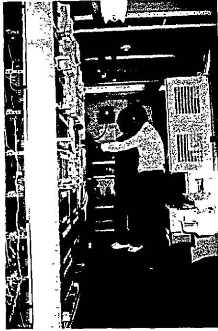
電子交換機内部
