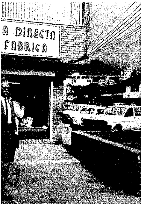
旧ボゴタ市内 軟弱地盤地域の不同沈下
