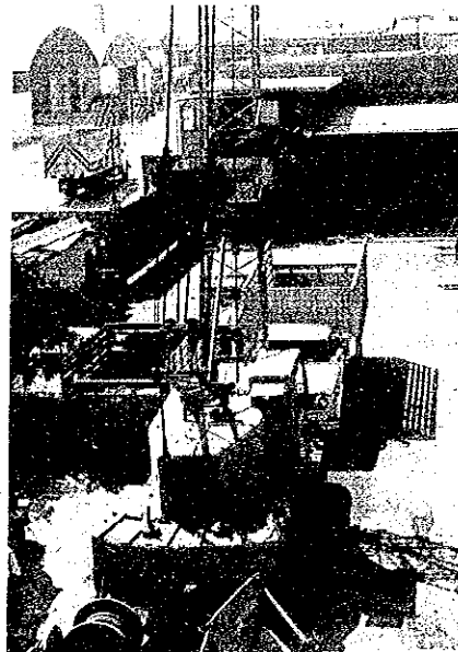
社屋裏の資材置場状況
