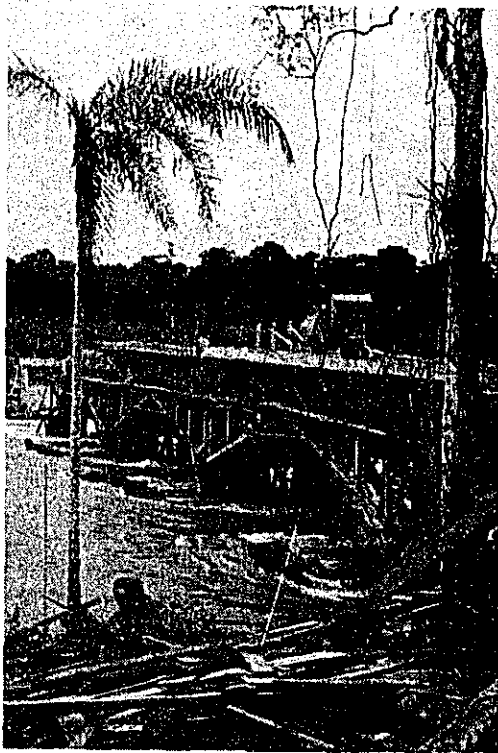
アカライ河（パラナ河支流） 発電所建設工事
