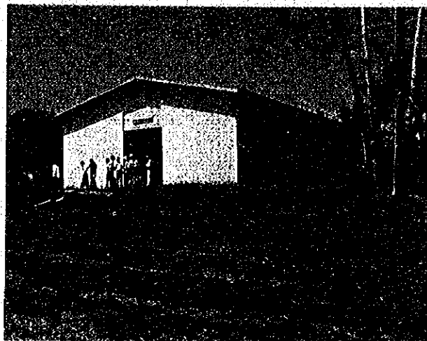
カピタミランダ農業試験場の種子倉庫 (第1次PIDAP計画による)
