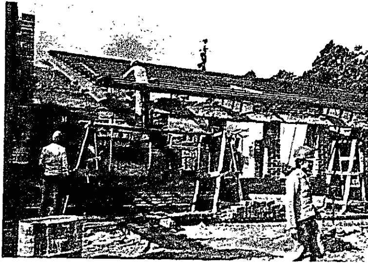
研修本館工事
