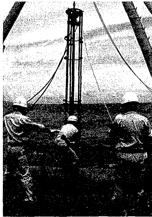
パイプコアラーの投入作業
