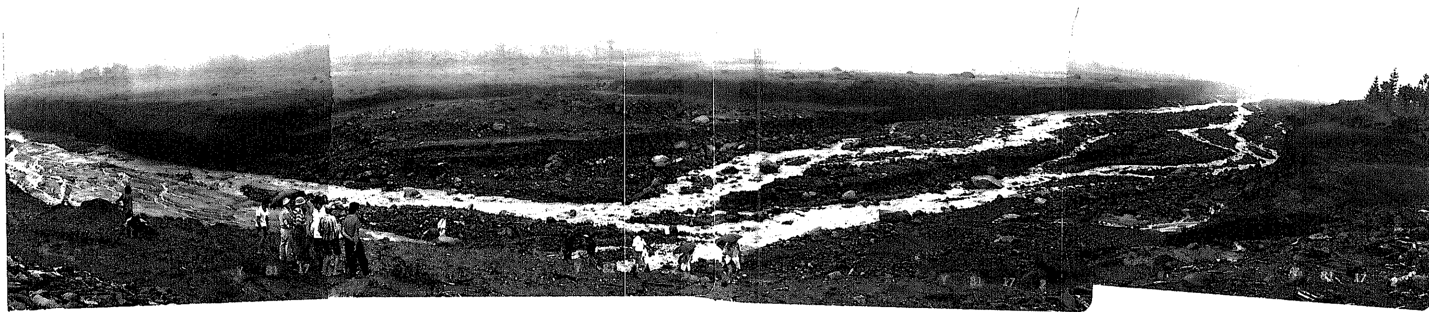
写真-8 堤防の被害 1981.5.14 災害直後のレセス堤防。河道断面が狭少かつ、河道法線が堤防直撃方向であったため破壊し下流の部落に被害を与えた。
