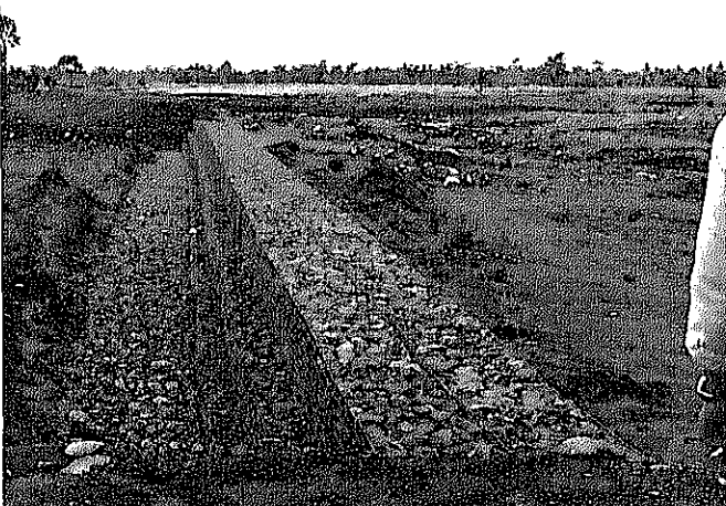
写真-10 堤防の復旧
