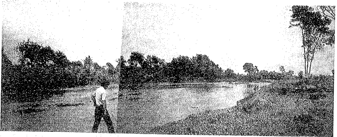
写真 4 - 5 - 1 改修工事上流端
