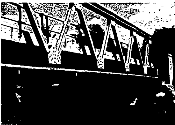
パッケージプログラムにより架設された オーストラリア製の鋼トラス橋
