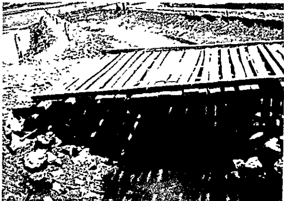
PANGKEP 県、整備された県道にかゝる木橋
