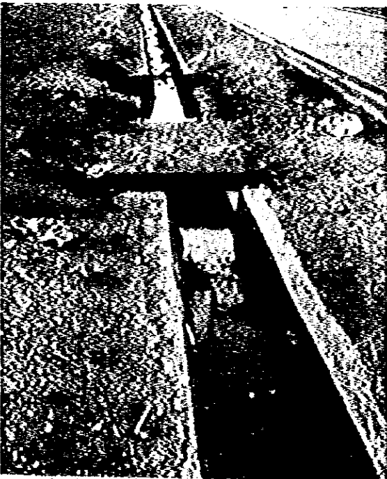
敷地回り排水溝
