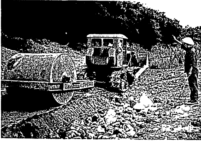
ダム材料現場転圧試験中（粗粒土質材料） 筑坝材料现场的压实试验（粗粒土质材料）
