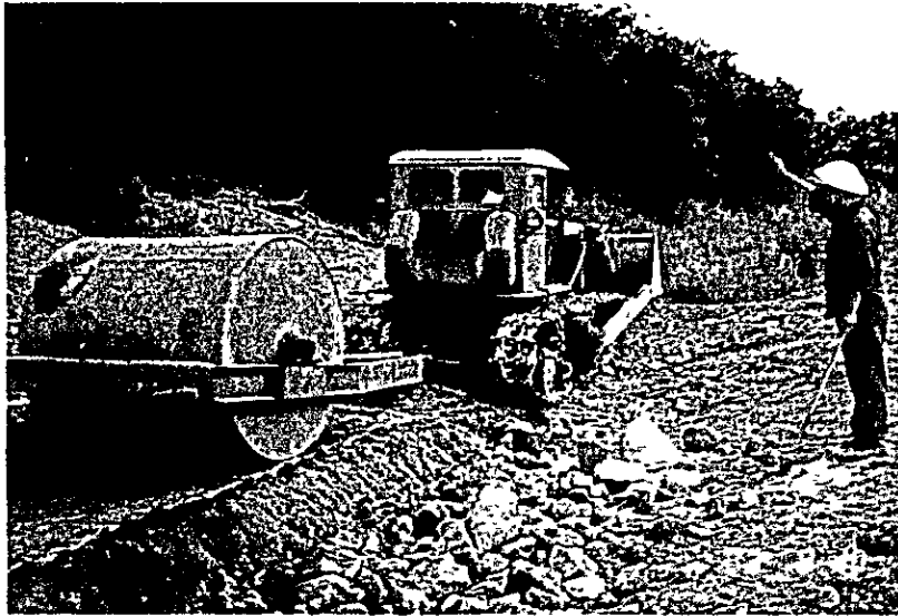
ダム材料現場転圧試験中（粗粒土質材料） 筑坝材料现场的压实试验（粗粒土质材料）
