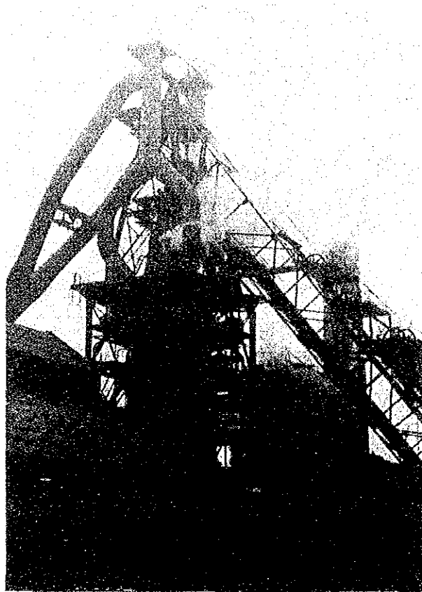
写真2 操業中の第1高炉（ 620m^2 ）
