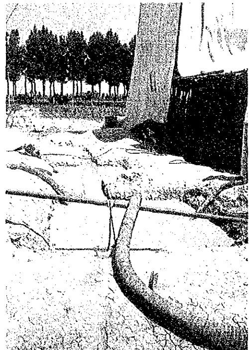
同上現場の泥水だめ
