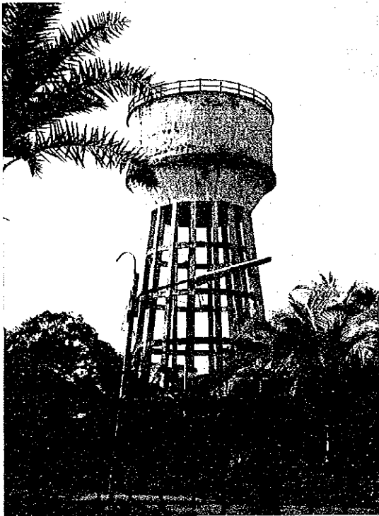
DPHE により建設された高架水槽 (Narayanganj)
