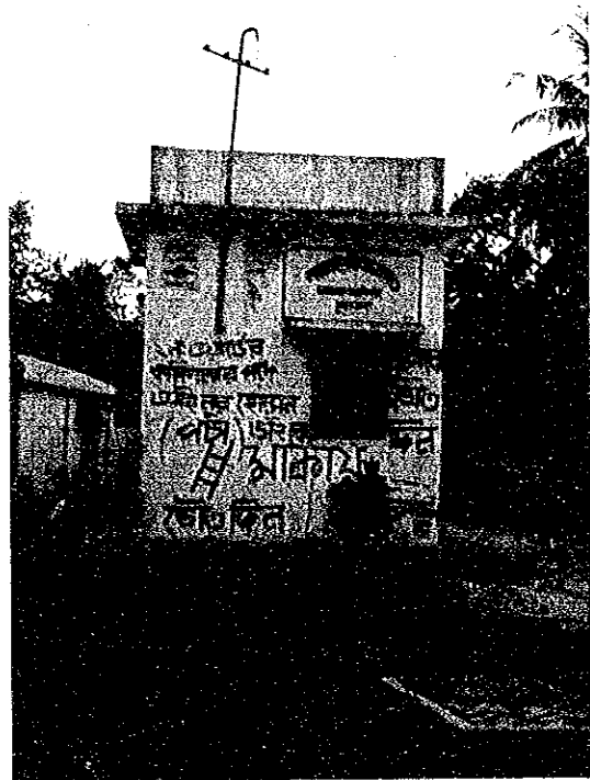
DPHE によって建てられた深井戸ポンプステーション (Chuadanga)
