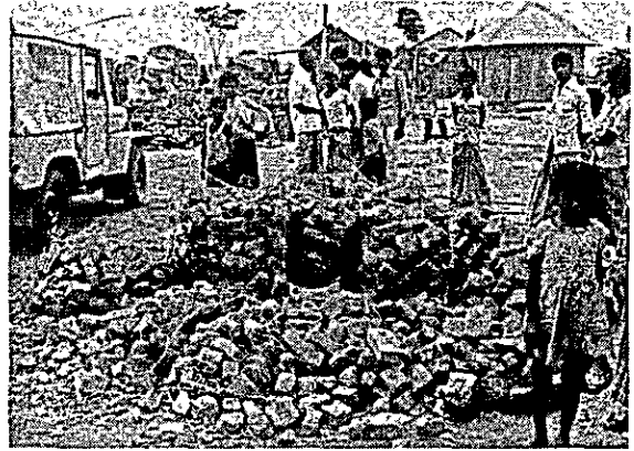
写真5-5.6 河岸浸蝕防護工の資材 (メグナ河左岸)
