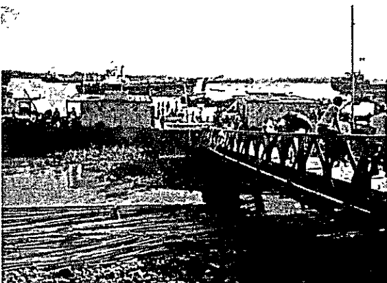
写真 3-2 チッタゴン市内の港（当地内でカルナフリ河を渡る浮橋を 1969 年 11 月に建設したが、翌年の洪水で流失、現在はその残がいを栈橋に利用している。）
