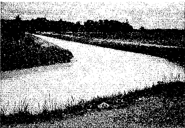
マレーシア：水管理訓練センターのパイロット・ファーム（No1）内のかんがい水路
