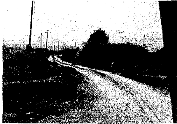
タイ： 北部地方道路網計画調査 未整備の地方道 —路面補修用の碎石が準備してある—
