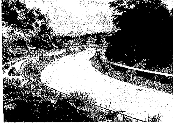
マレーシア : 全国水資源開発計画調査 首都を貫流するクラン河 - 河川改修ずみの中流部区間 -
