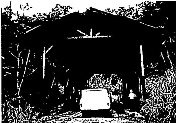
木橋の桁保護（防腐）のための屋根（ミンダナオ）
