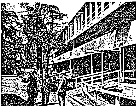
建築中のハラケマダ病院
