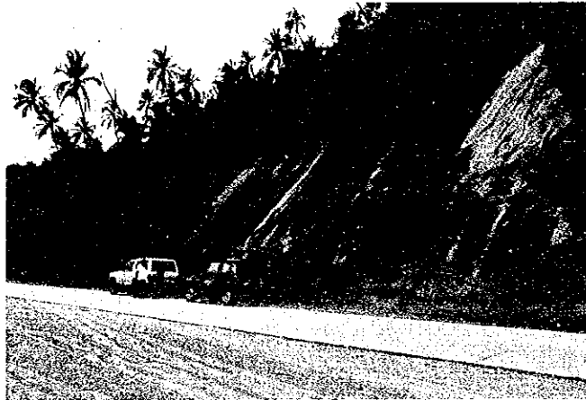
写-29 ルセナ〜カラワグ区間K・P 175附近より 東方にかけてみられる砂岩・泥岩の互層の切土面の状況
