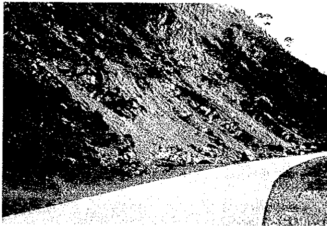
写-2 アゴ-パギオ道路K・P 278附近の大規模切土崩壊
