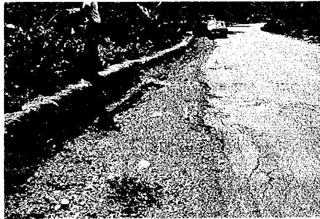
写-23 写-22と同じ状況
