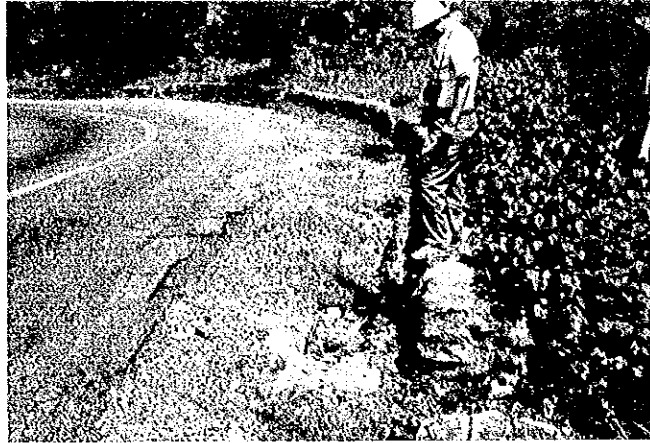
写-22 ナギリアン道路に多く見られる路面 排水の不良による路肩部の損傷状況
