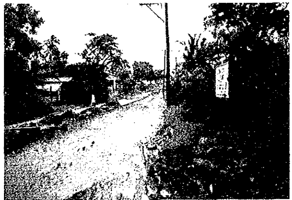
Lucena 市のバイパスの中央付近の市内方向への 取付道路（舗装工事中）
