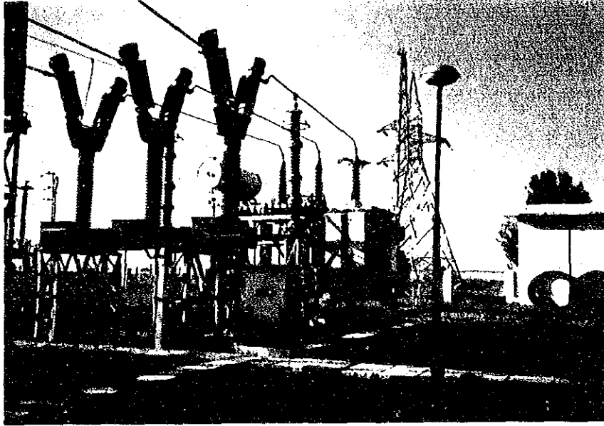
リソット変電所（ラウルピンジ）
