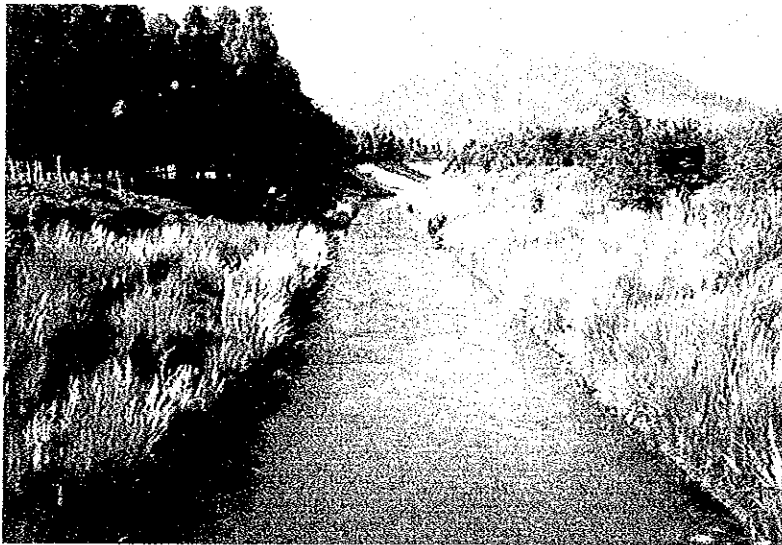
カンプールダム左岸水路 昭和61年8月
