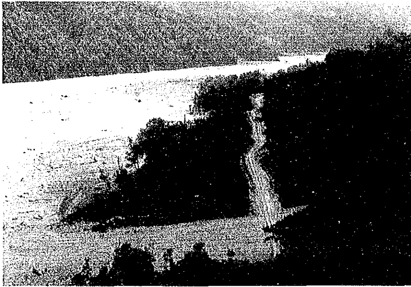
(写-19) ネパール政府により建設中のシンズリ道路。河川横過等の架橋地点で寸断されている。橋梁工事は、ネパール政府にとっては困難なようである。
