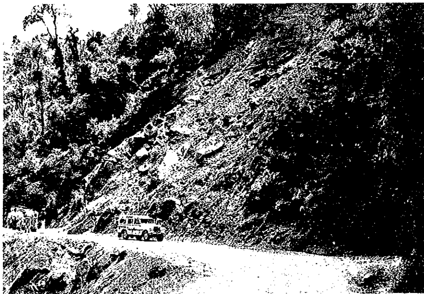
(写-18) トリブバン道路での斜面崩壊。この道路に限らず、山岳道路においてはこのような崩壊がずい所に見られる。
