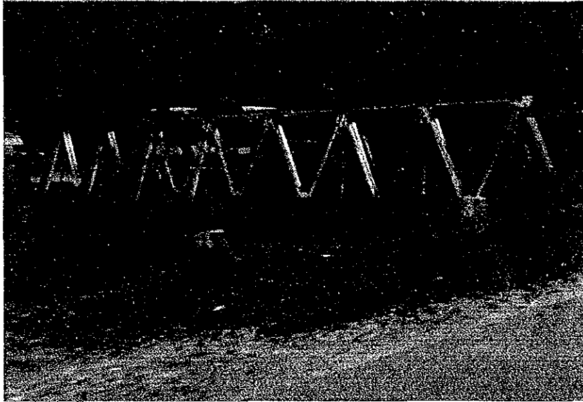
(写-11) ムグリン道路の橋梁、重量制限は9t、貨物がコンテナ化したら架替えが必要。
