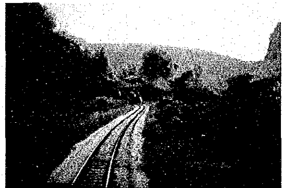
急勾配、急曲線部（難所区間）
