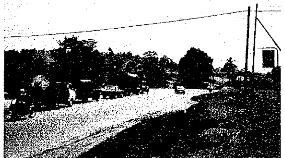
18 Federal Route 1 より Lorry Route を見る
