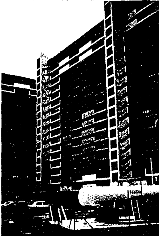
公営住宅簡易ガスシステム
