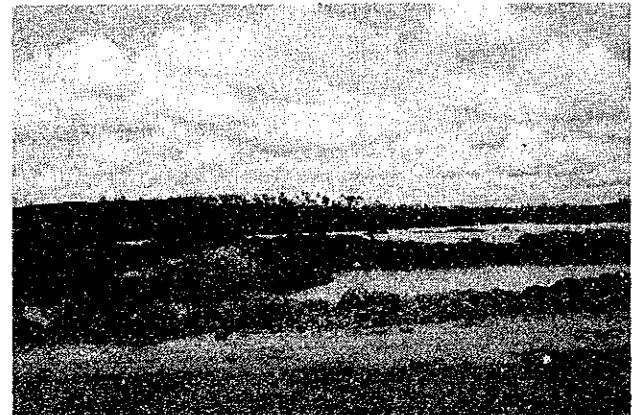
建設中 Layang Dam 貯水予定地
