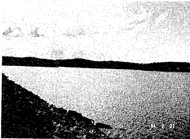
Machap Dam メインダム(左下)と貯水池
