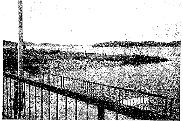
Machap Dam 洪水吐(下)と貯水池
