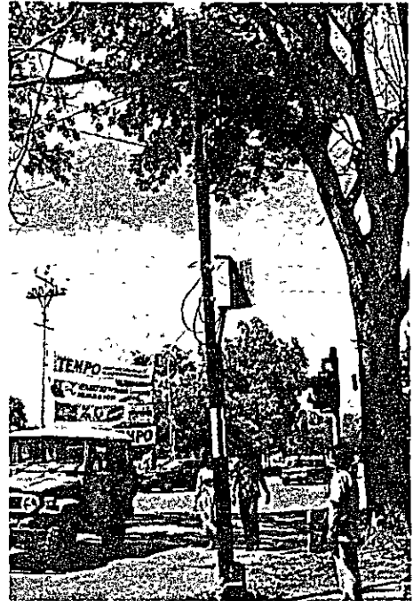
メダン市内の引上げ柱と端子函
