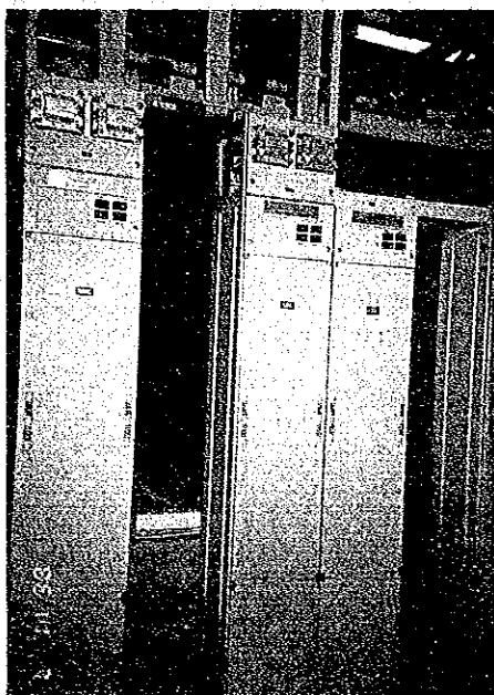
トランス・スマトラ回線の送受信装置 (メダン搬送無線中継所)
