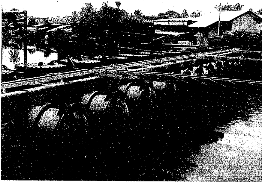
プラカノン排水機場
