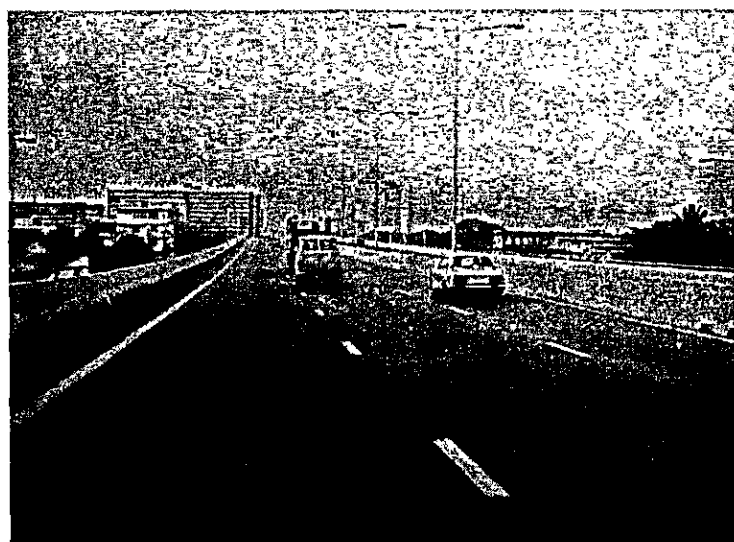
写真 - 8 供用中の Din Daeng-Port 線(2) ( Sukhumvit Road ~ Rama V Road 間 )
