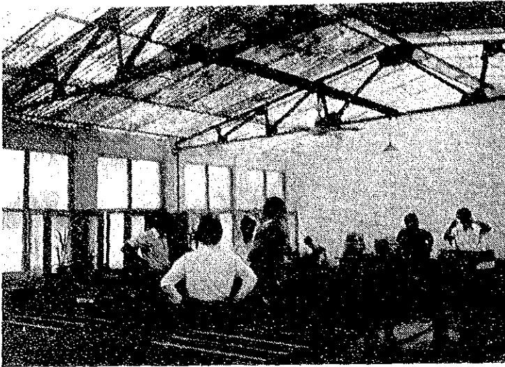
グリーンハウス内部 屋根はプラスチック製
