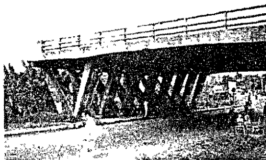
A1・A3 道路交差点に一部建設済の フライオーバー
