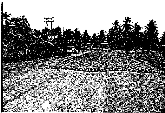
Biyagama I. P. Z 予定地へのアクセス道路 建設状況
