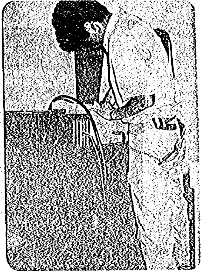
ケーブルと記録部の結線
