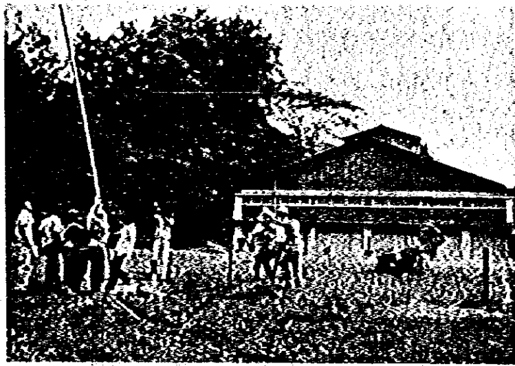
写真 1-4-3 風向風速計ポールを設置
