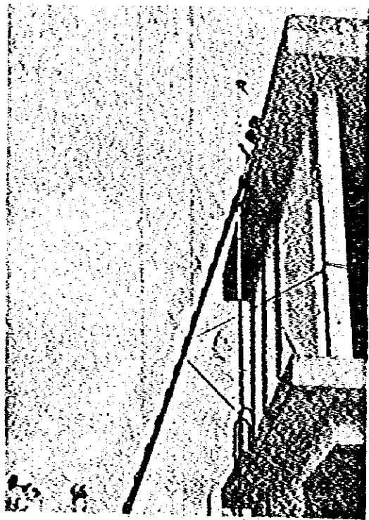
写真Ⅰ-1-4(3) 風向風速計用ポールの設置
