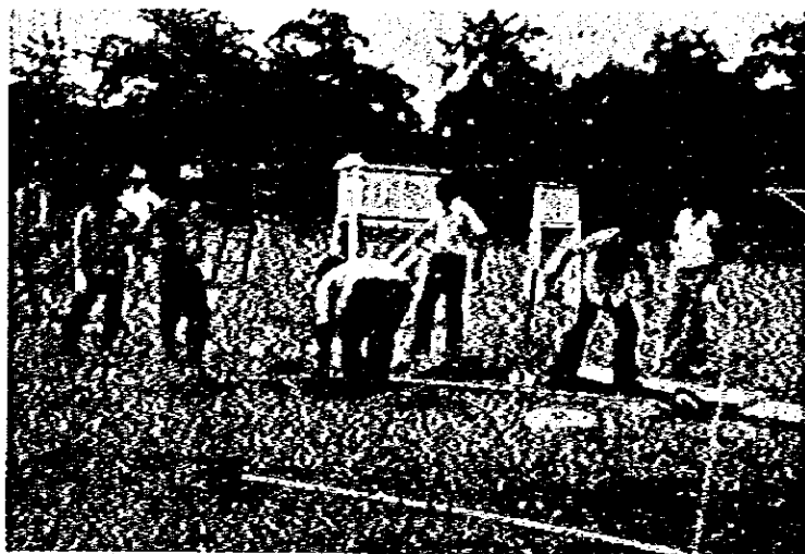
写真Ⅰ-1-1(7) MP1の気象計器 ケーブルの埋設
