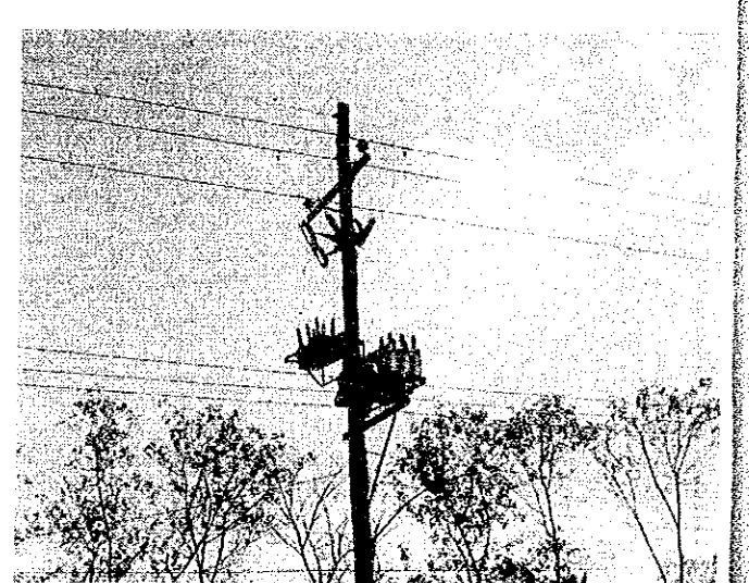
④ 敷地に電力引き込み可能な電柱
