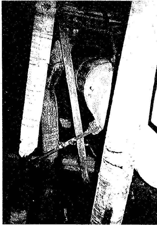
S-1 低温再熱器管近くの曲っているアイビーム
