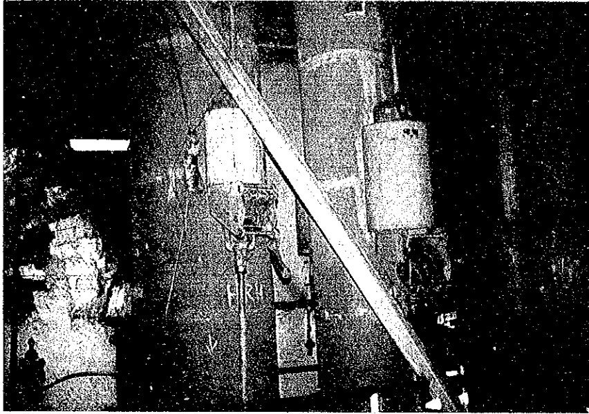
S-1 主配管のサポート（定荷重ハンガーの機能が失われている）
