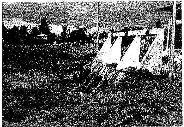
基幹構造物(バジンテラップ揚水機場)
