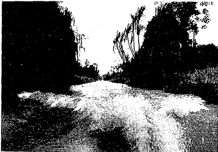
ティンギ川 左・右岸とも湿地帯 部分に深淺があり、ドレッジャー1台により改修してい る。 川巾約12m（改修後25m程度）
