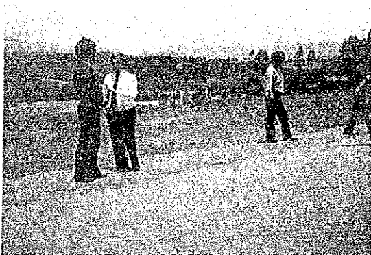
写真18 新クスコ空港調査風景
