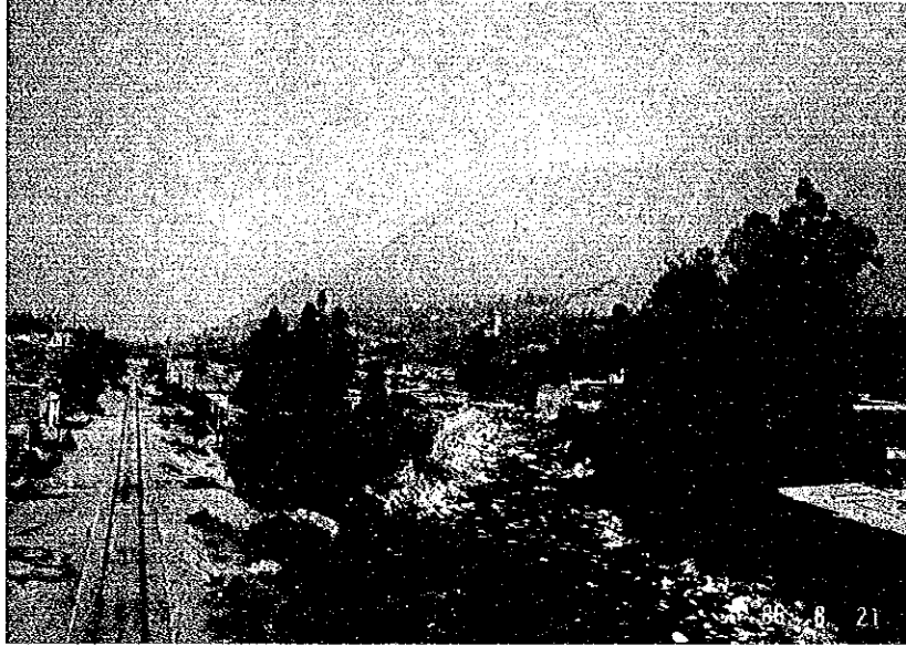
P - 9 Chosica下流のLos Angeles橋直下の河状
