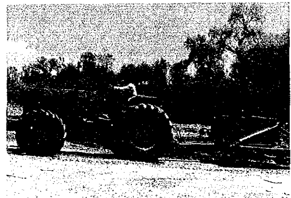
トラクターによる整地状況
