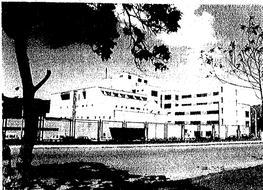
Figura 3: Vista exterior del Hospital Departamental de Nariño
