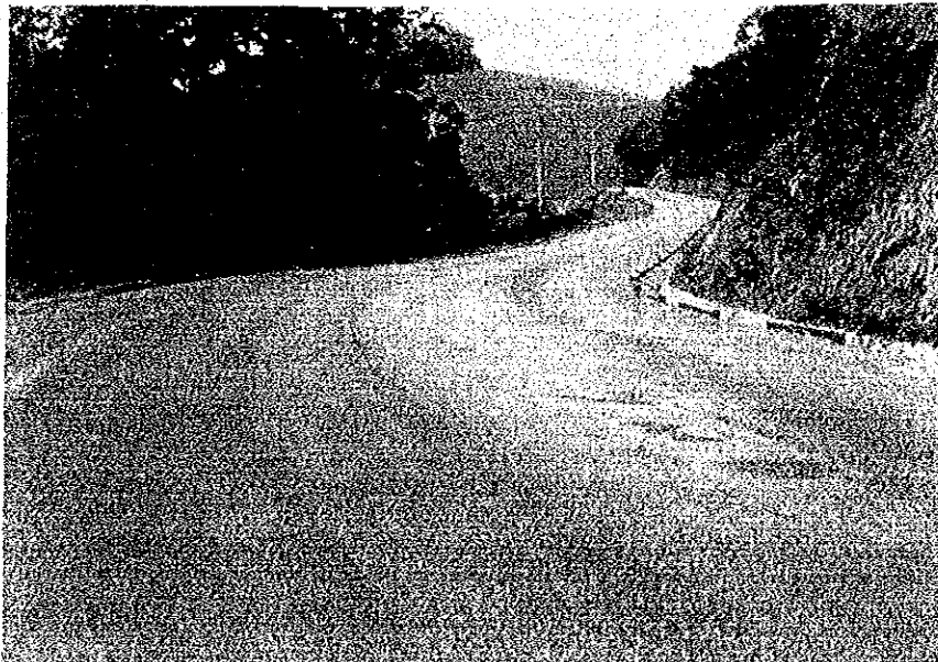
完成部（浸透工法）
