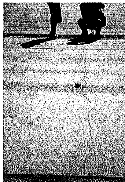
写真5-2 滑走路のひび割れ状況
